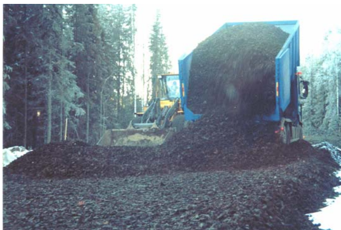
Figur 4.5 Lossning av gummiklipp från flisbil samt utläggning och justering med hjullastare.
